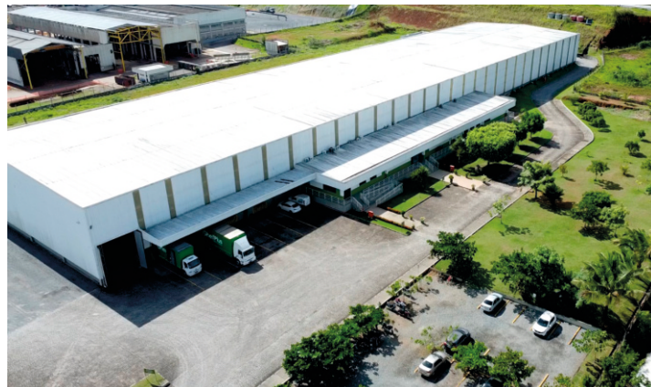
UNIDADE FABRIL - ESCADA/PE
