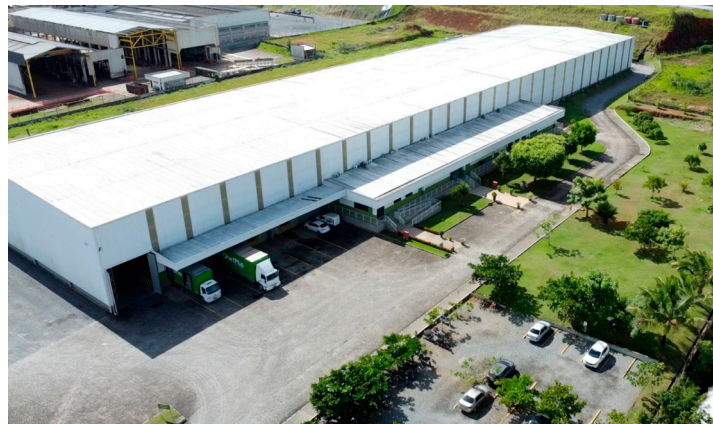
UNIDADE FABRIL - ESCADA/PE
